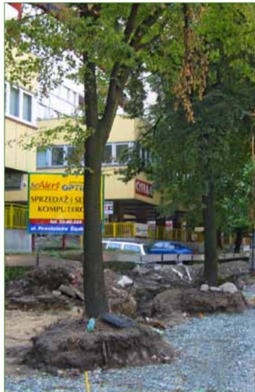
Fot. 6. Przykład drzew, które wskazano do zachowania. Po zakończeniu inwestycji nie mają szans na przeżycie. Fot. Monika Ziemiańska
